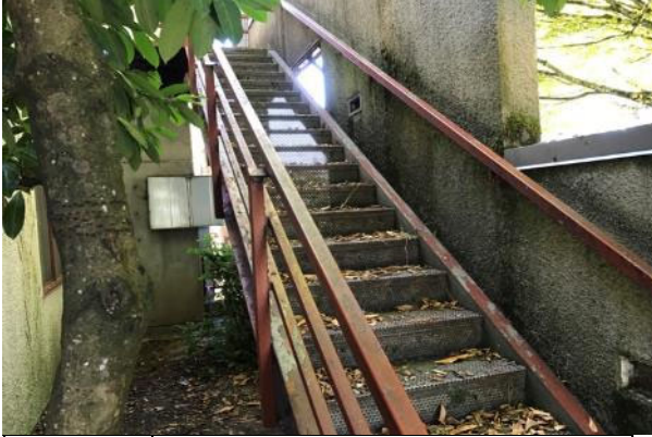
#73 EXTERIOR METAL STAIRS
