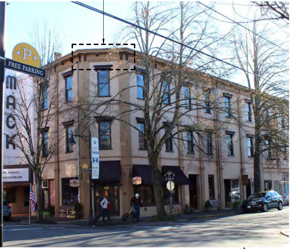
GROUPED CORNICE BRACKETS
