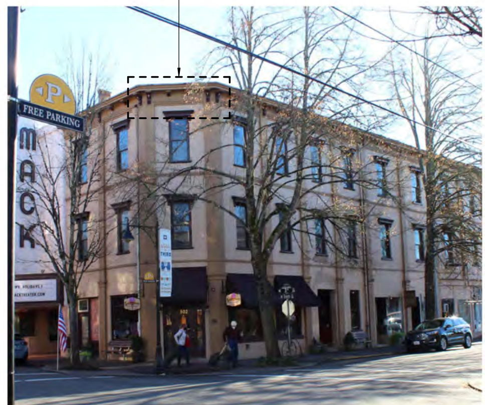
GROUPED CORNICE BRACKETS
